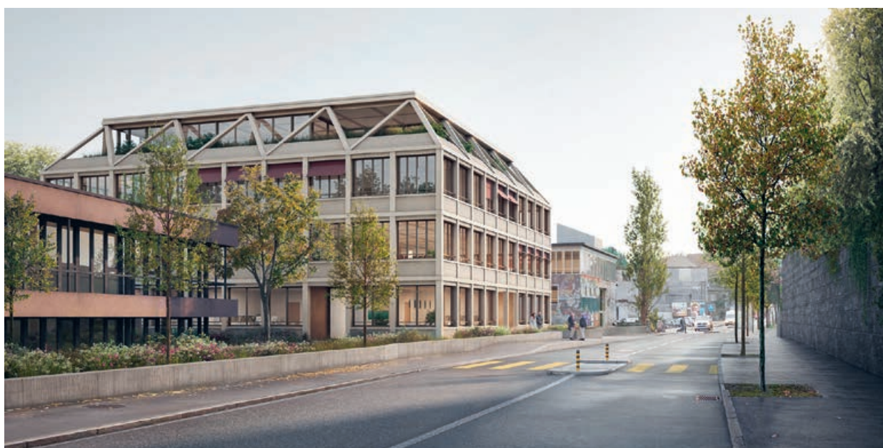
Projet de construction du nouveau bâtiment au Faubourg du Jura 42 à Biel/Bienne.
